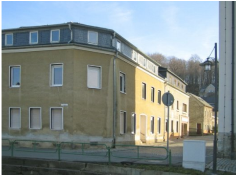
Gebäude vor Baubeginn
