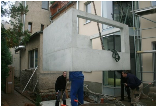
Montage Schallschutzumhausung
