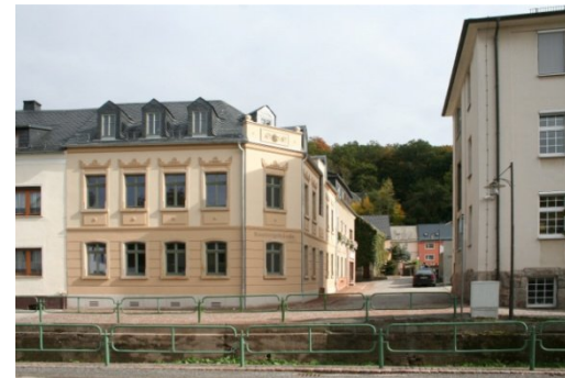
Gebäude nach Fassadensanierung
